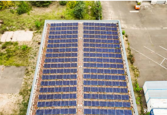
Auch das Dach des Kreisarchivs Eberswalde wurde mit Solarmodulen zur Versorgung des Gebäudes ausgestattet.
