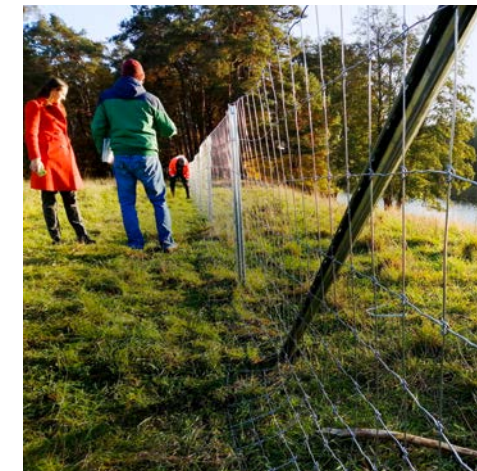
Bis August 2021 hat die KIS insgesamt 23 Kilometer Zaun zum Schutz vor Wildschweinen mit der Afrikanischen Schweinepest errichtet. Zum Einsatz kamen 5.750 Zaunpfosten und 1.500 Stützstreben.
