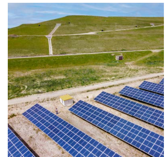
Die PV-Anlage auf der Deponie Ostend soll perspektivisch erweitert werden, so dass bald rund 38.000 Module Strom für den Barnim erzeugen können.
