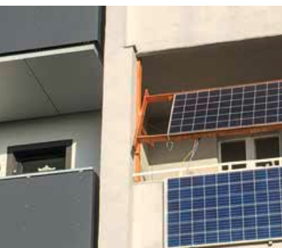
Mit neuen Lösungen die Energiewende forcieren: Ein Balkonkraftwerk lässt auch Mieter*innen eigenen Strom gewinnen.
